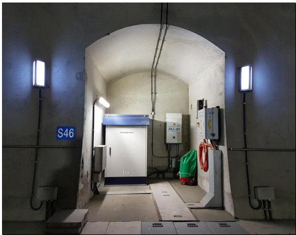
터널 내부 기재갱(대피소) 전경
