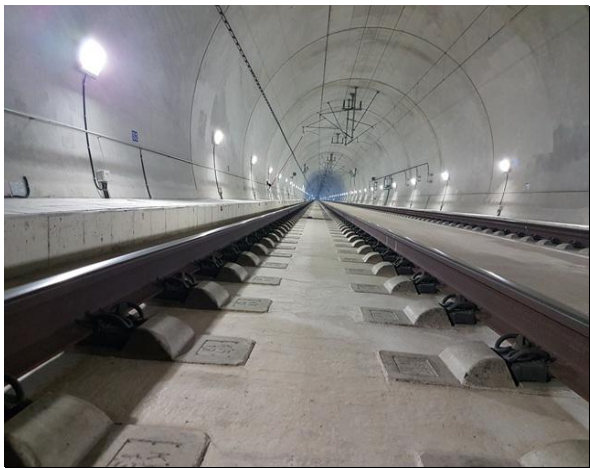
콘크리트 도상 전경
