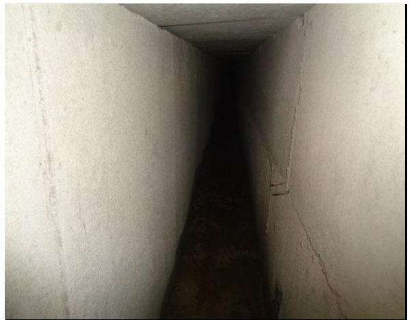
배수로 내부 전경
