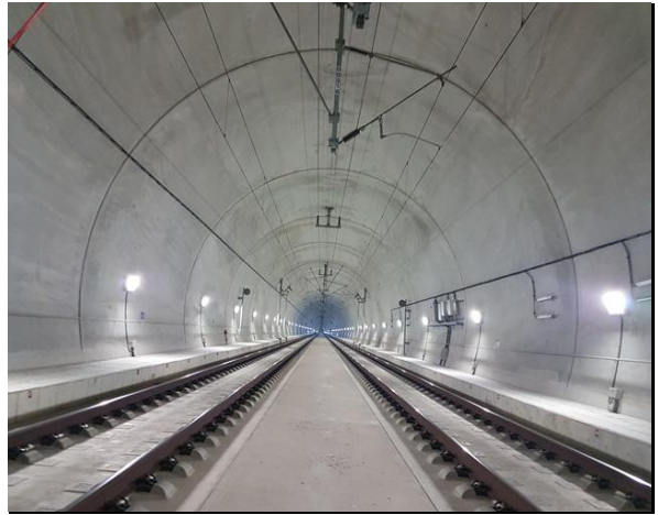
터널 내부 전경
